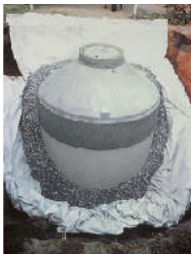
Regenwasserspeicher kombiniert mit Rigolenversickerung
