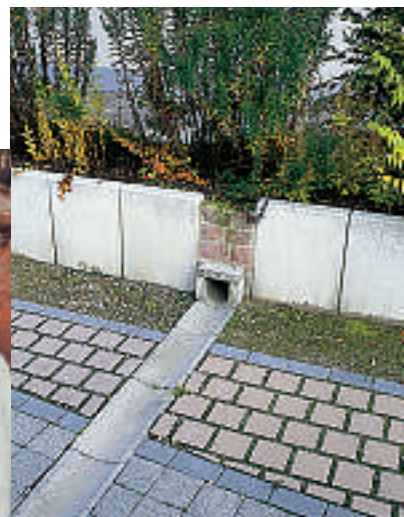
Überlauf Regenwasserspeicher in Mulde
