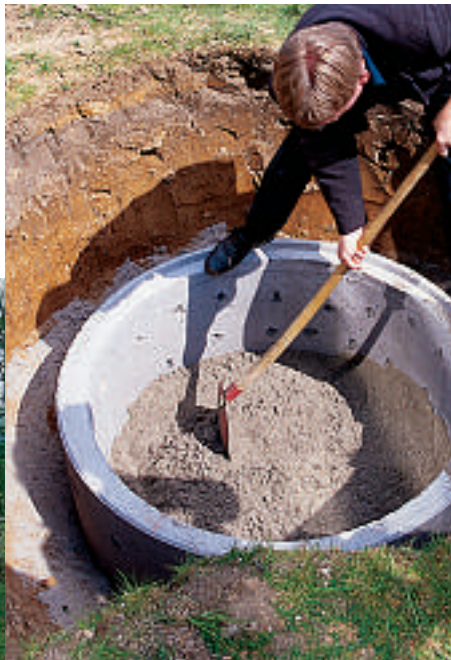
Schachtversickerung im Bau
