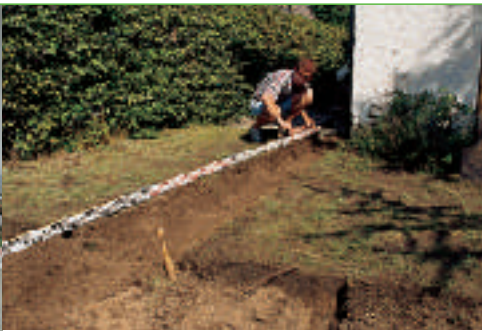
Oberflächige Zuleitungen von Regenwasser in Mulden
