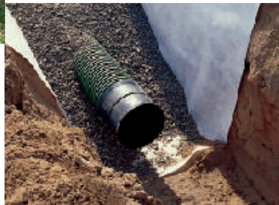
Rohr-Rigolenversickerung im Bau
