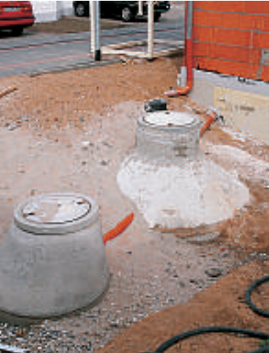
Filter, Regenwasser- speicher, Sickerschacht
