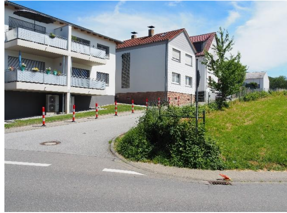
Foto 21: Schützengasse Zweigeschossige Wohnbebauung
