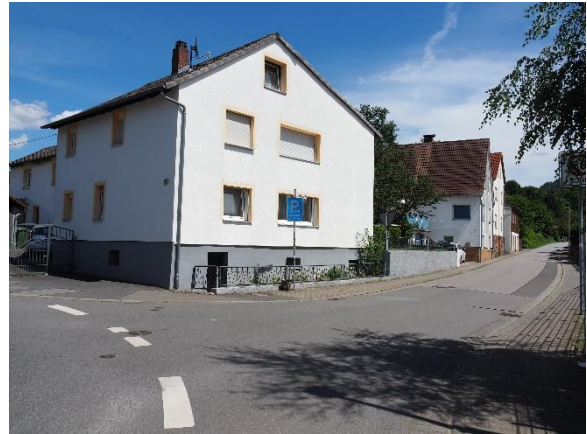
Foto 8: Ecke Kröckelbacher Straße / Erzbergstraße
