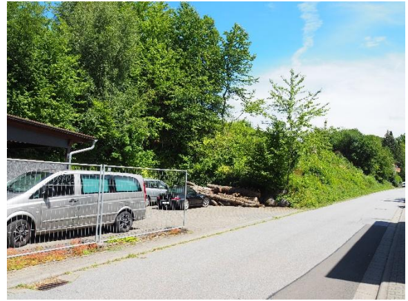
Foto 4: Böschung Erzbergstraße Blickrichtung von Nordwesten nach Süden
