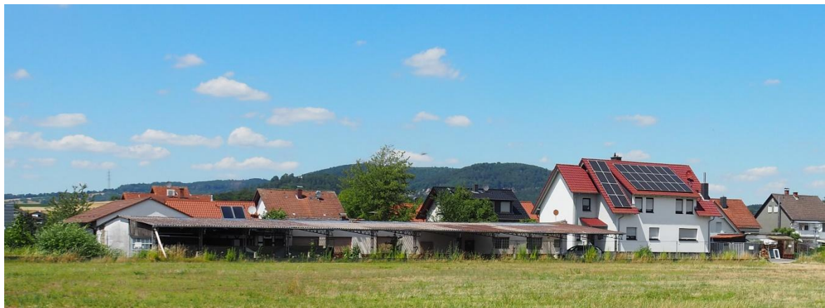
Foto 22: ehemalige Vereinsgebäude, Bestandsgebäude Gerhart-Hauptmann-Straße Nr. 7
