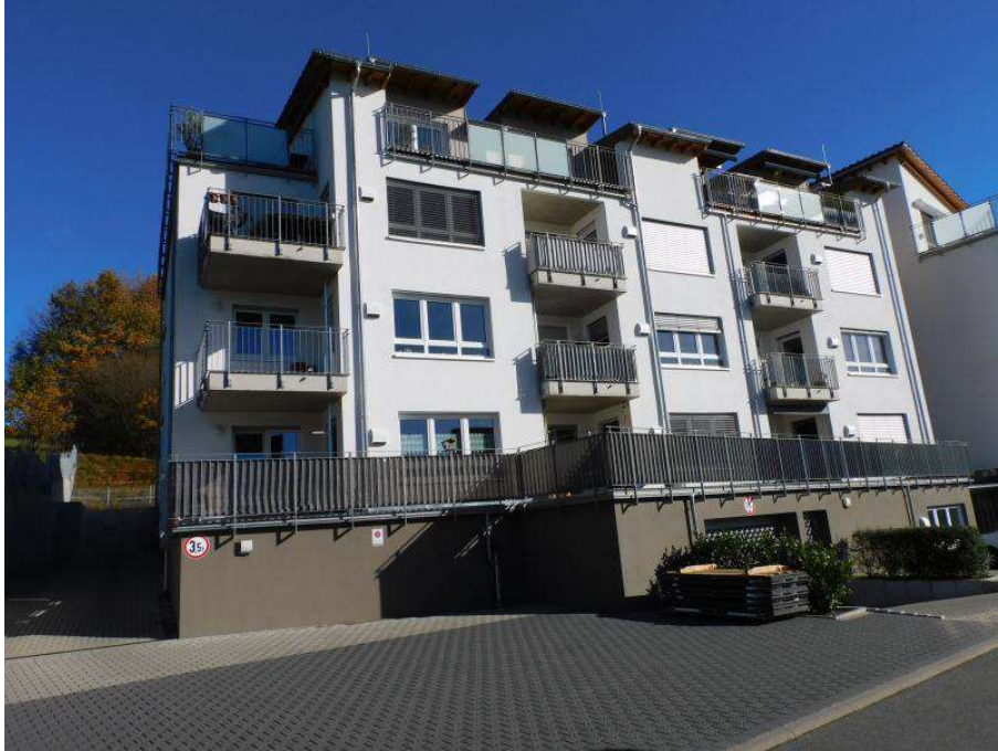
Abbildung 14: Blick von Westen auf die mittlerweile fertiggestellte Blockbebauung ‚Betreutes Wohnen‘ (Quelle: Artenschutzprüfung Dr. Winkler)
