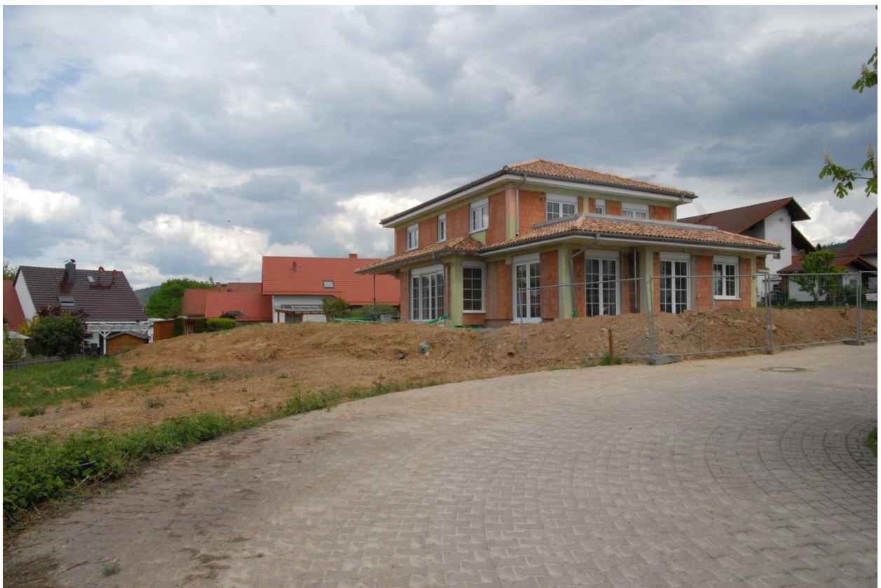
Foto 3 Baustelle auf Flurstück 234
