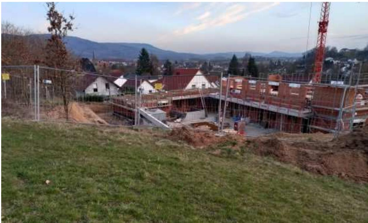
Abbildung 3: Baugrube mit Rohboden (Fl.7 und Fl.8)
