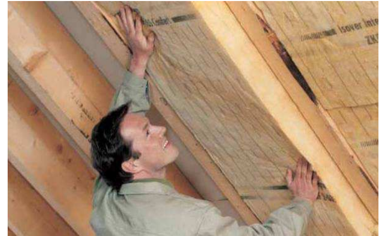
Zwischensparrendämmung
