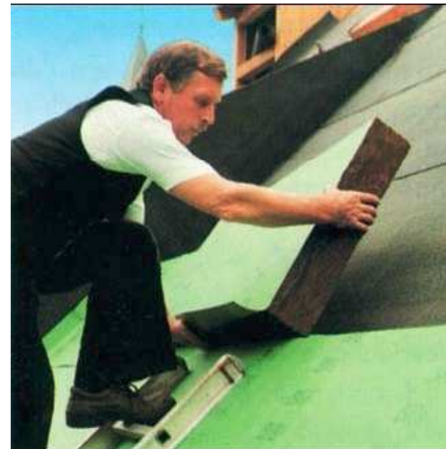
Aufwendig: Dichtung im Sparrenbereich
