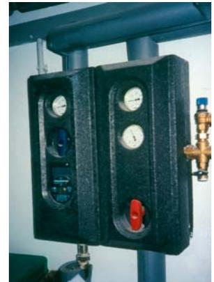
Pumpen und Armaturen sollten heute mit entsprechend geformten Hartschaumschalen gedämmt werden
