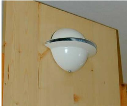
Zuluftventil in Form einer „Weitwurf-düse“; hier eingebaut in ein Regal.
