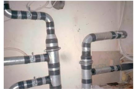
Von unten gegen die Decke fotografiert: Teile eines Kanalnetzes aus Wickelfalzrohr. Alle Verbindungen sind zum Schutz gegen Leckagen mit elastischem Klebeband verschlossen.
