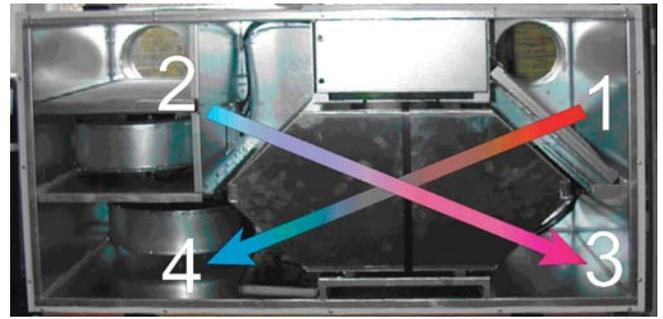
Blick in ein Lüftungsgerät mit Kreuzgegenstromwärmetauscher. Links sind die beiden Lüfter zu erkennen.
