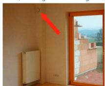
Zuluftventil über einem Heizkörper
