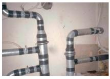
Von unten gegen die Decke fotografiert: Teile eines Kanalnetzes aus Wickelfalzrohr. Alle Verbindungen sind zum Schutz gegen Leckagen mit elastischem Klebeband verschlossen.
