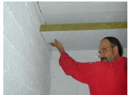
Dämmung einer Kellerdecke mit 6 bis 8 cm starken Dämmplatten von unten beseitigt die „Fußkälte“ in der Erdgeschosswohnung.
