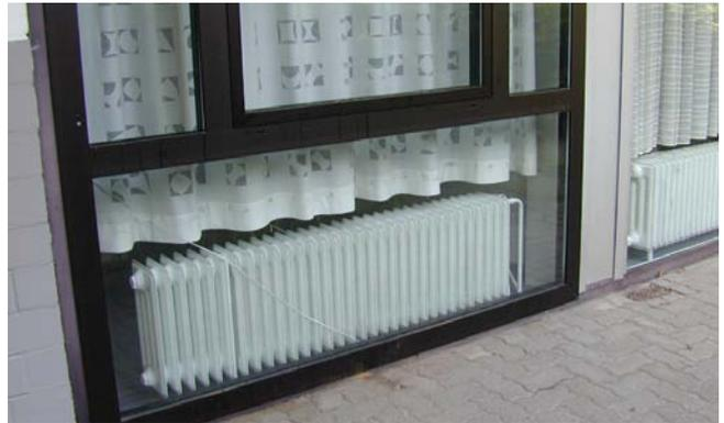
So etwas wurde leider häufiger gebaut: Heizkörper direkt vor der Fensterscheibe. In so einem Fall sollten Sie unbedingt reflektierende Heizkörperdämmplatten vor dem Fenster befestigen. Denn erstens braucht der Heizkörper keine gute Aussicht und zweitens können Sie die Wärme, die er abstrahlt, drinnen besser gebrauchen.
