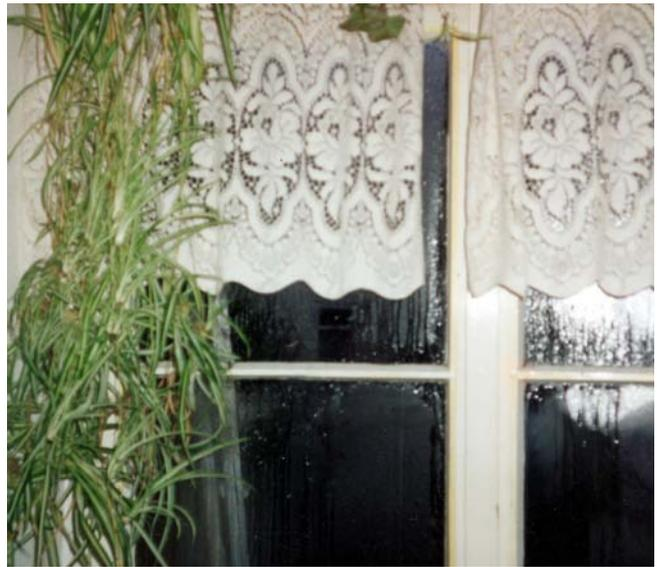
Ablaufendes Kondenswasser an einem einfach verglasten Fenster
