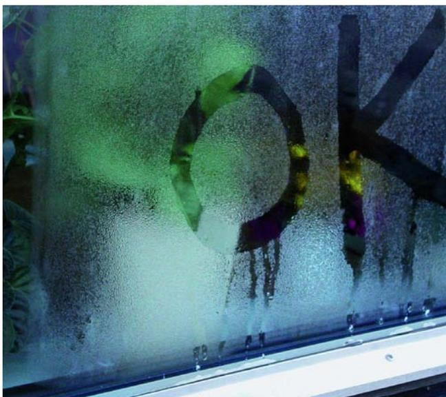
Außenkondensat am frühen Morgen auf einer Wärmeschutzverglasung ist ein Zeichen dafür, dass der Wärmetransport von innen nach außen sehr gering ist.
