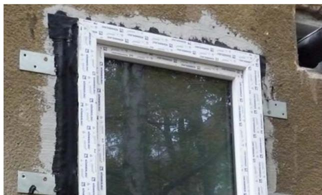
Montage eines Fensters vor dem Mauerwerk im Rahmen einer Modellsanierung, wobei die Abdichtung mit Glattstrich und Butylkautschukband erfolgt.
