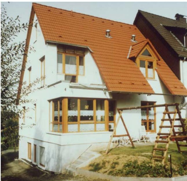
40 - 60 Prozent Fensterflächenanteil der Südfassade sind beim Niedrigenergiehaus genug. Wichtig für die passive Solarenergienutzung ist der Einsatz einer guten Wärmeschutzverglasung mit U-Werten kleiner oder gleich  $1,1 \text{ W}/(\text{m}^2\text{K})$ . Empfehlenswert ist, Verschattungseinrichtungen vorzusehen.
