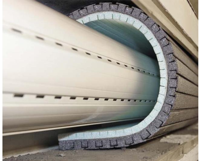
Der Rollladenkasten, dessen inneres mit der kalten Außenluft in Verbindung steht, sollte möglichst gut gedämmt sein. In Baumärkten sind biegsame Dämmelemente erhältlich, die sich leicht in den vorhandenen Rollladenkasten einschleiben lassen. Für eine gute Wirkung ist es wichtig, dass sie exakt eingepasst und wenn nötig an den Seiten abgedichtet werden.
